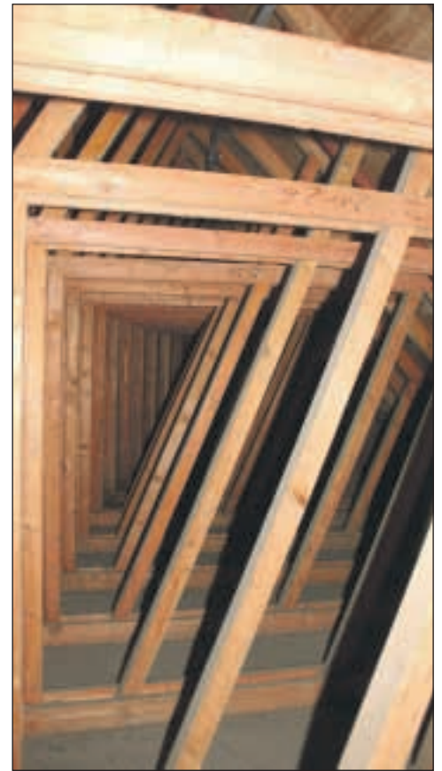
260 Binder stützen die Bahn, auf der Erik Zabel & Co. sechs Tage lang ihre Runden drehen.
