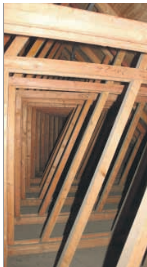
260 Binder stützen die Bahn, auf der Erik Zabel & Co. sechs Tage lang ihre Runden drehen.
