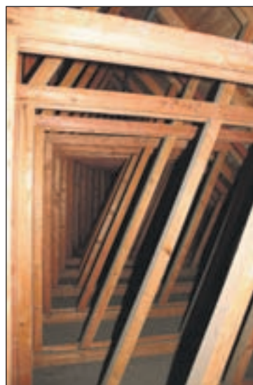
260 Binder stützen die Bahn, auf der die Fahrer sechs Tage lang ihre Runden drehen.
